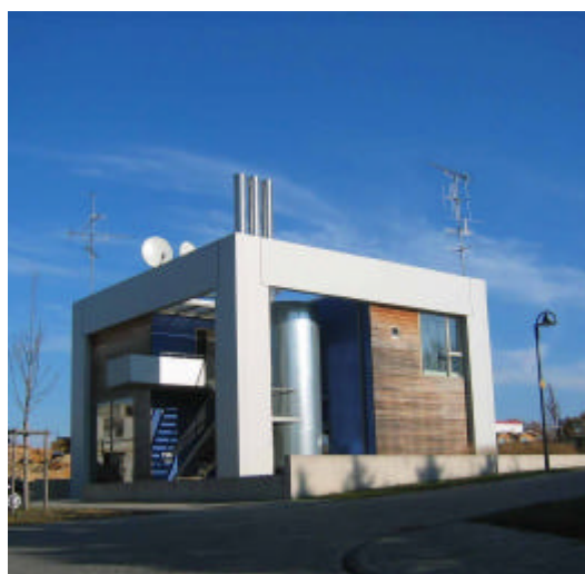
Technikzentrale mit Blockheizkraftwerk und Multimediazentrale
