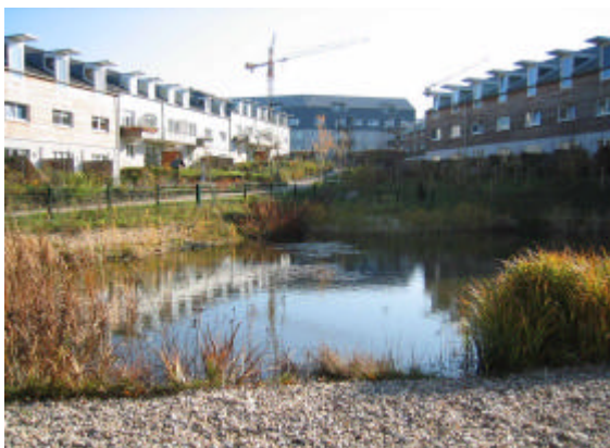
Die Regenwasserversickerung hat aufgrund der Nähe zum Quellgebiet des Borkhauser Baches Vorrang vor der Regenwassernutzung.
