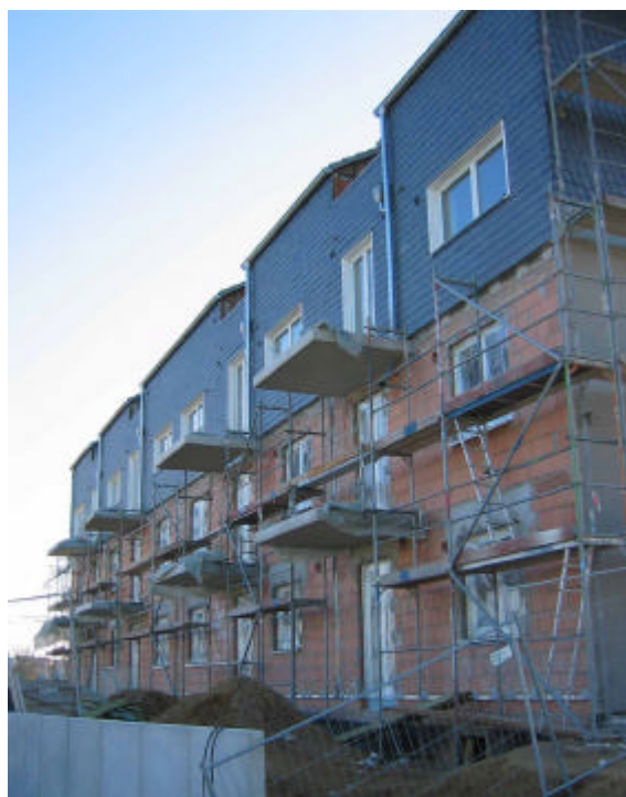
Blick auf die Porotonziegel der Außenwand
